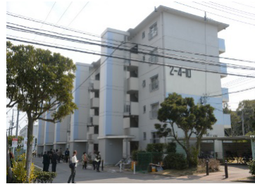
外付けエレベーター
